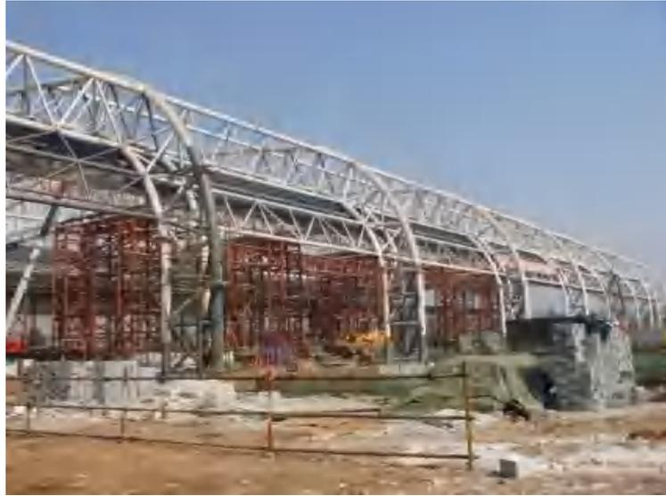
北戴河站钢桁架结构施工过程监测
